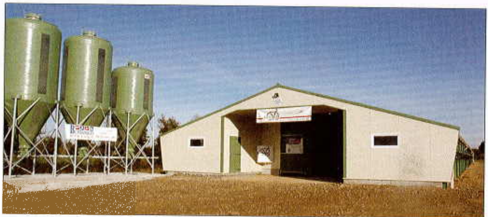
▲ Le poulailler de 1 368 m 2 (Dugué, 1 300 m 2 de surface utile) a coûté 230 691 € (168,6 €/m 2 ), sachant que l'éleveur et son beau-père ont réalisé certains travaux par eux-mêmes (terrassement, pose des longrines, montage du matériel, aires bétonnées extérieures, carrelage du sas sanitaire).
