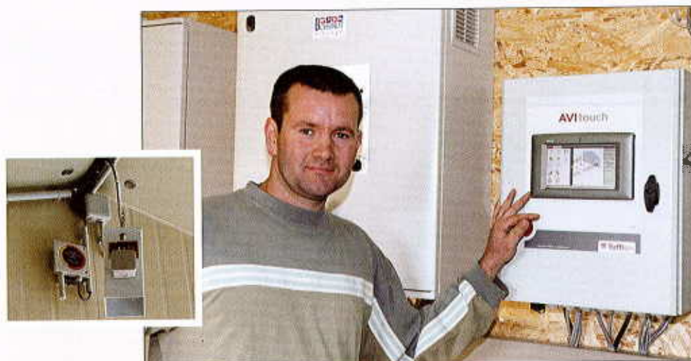
▲ Chez Benoît Hay, le boîtier de régulation Avitouch (Tuffigo) et la sonde hygrométrique extérieure à saturation (Pack besoin Auto) vont permettre d'ajuster la ventilation en fonction du taux d'humidité réel de l'air extérieur. Avantages escomptés : optimisation du temps de fonctionnement des turbines, meilleure ambiance, réduction des dépenses en gaz.
