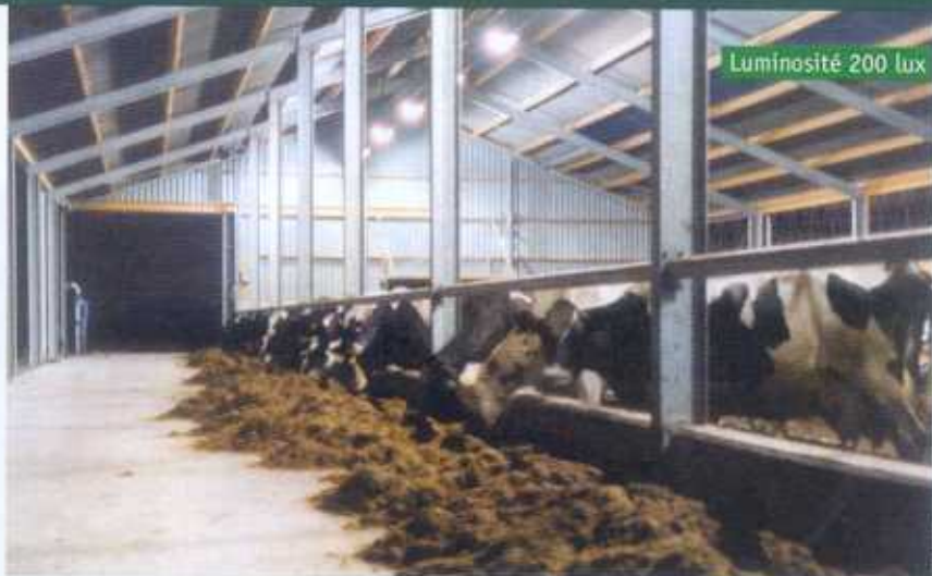
Une seule rangée de luminaires pour un éclairage à 200 lux.
